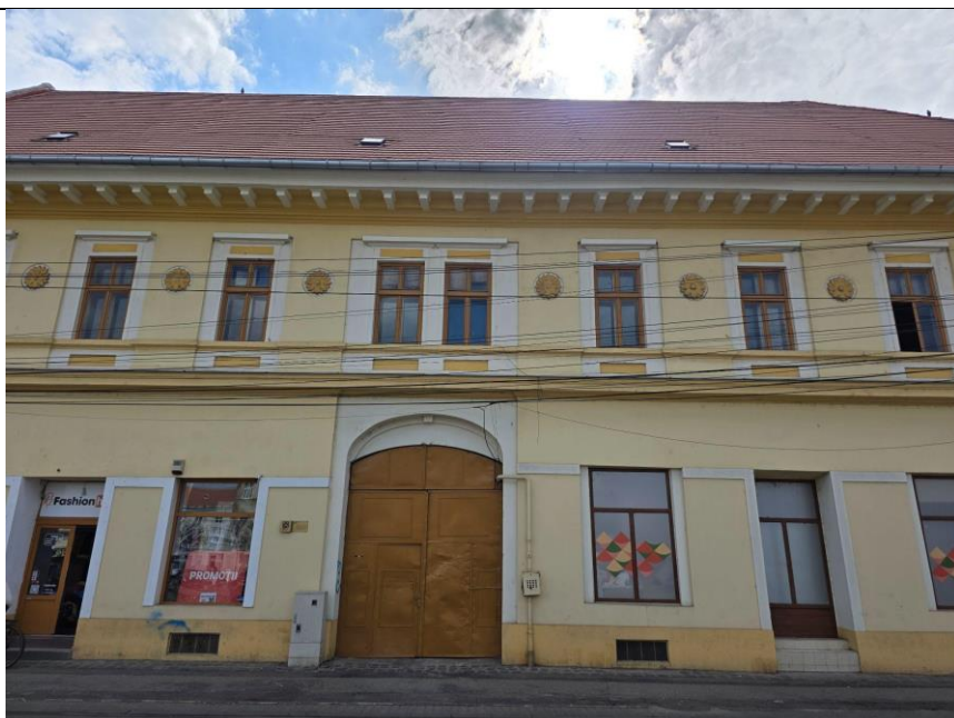
Imaginea 9 – Fațada de la Piața Traian - gangul de acces 409
