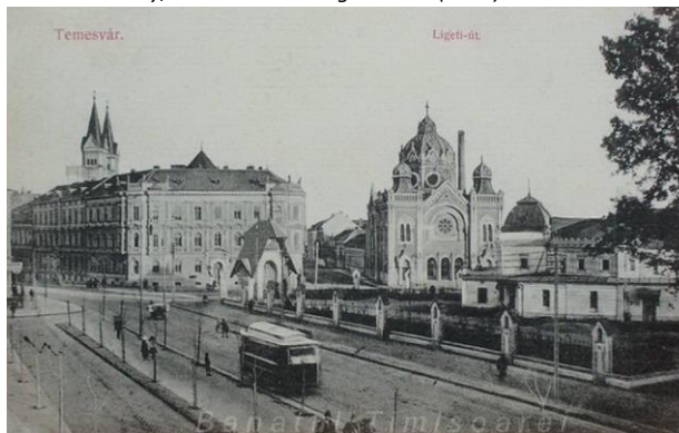
Vedere către Parc și Sinagogă 70
